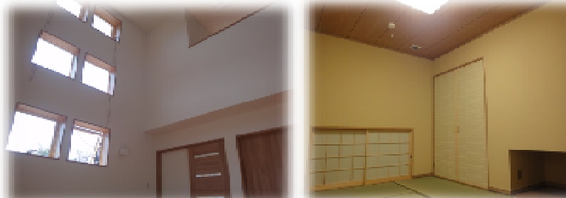
和室はマイナスイオンを発生する健康塗り壁ダイアトームスを使用。
