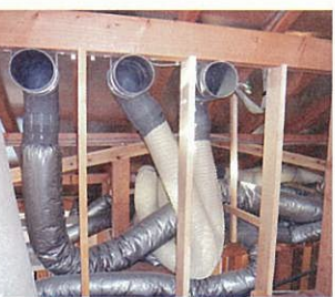
小屋根には、新鮮な空気を取り入れて計画換気をする チューブがぎっしり =家康工房提供
